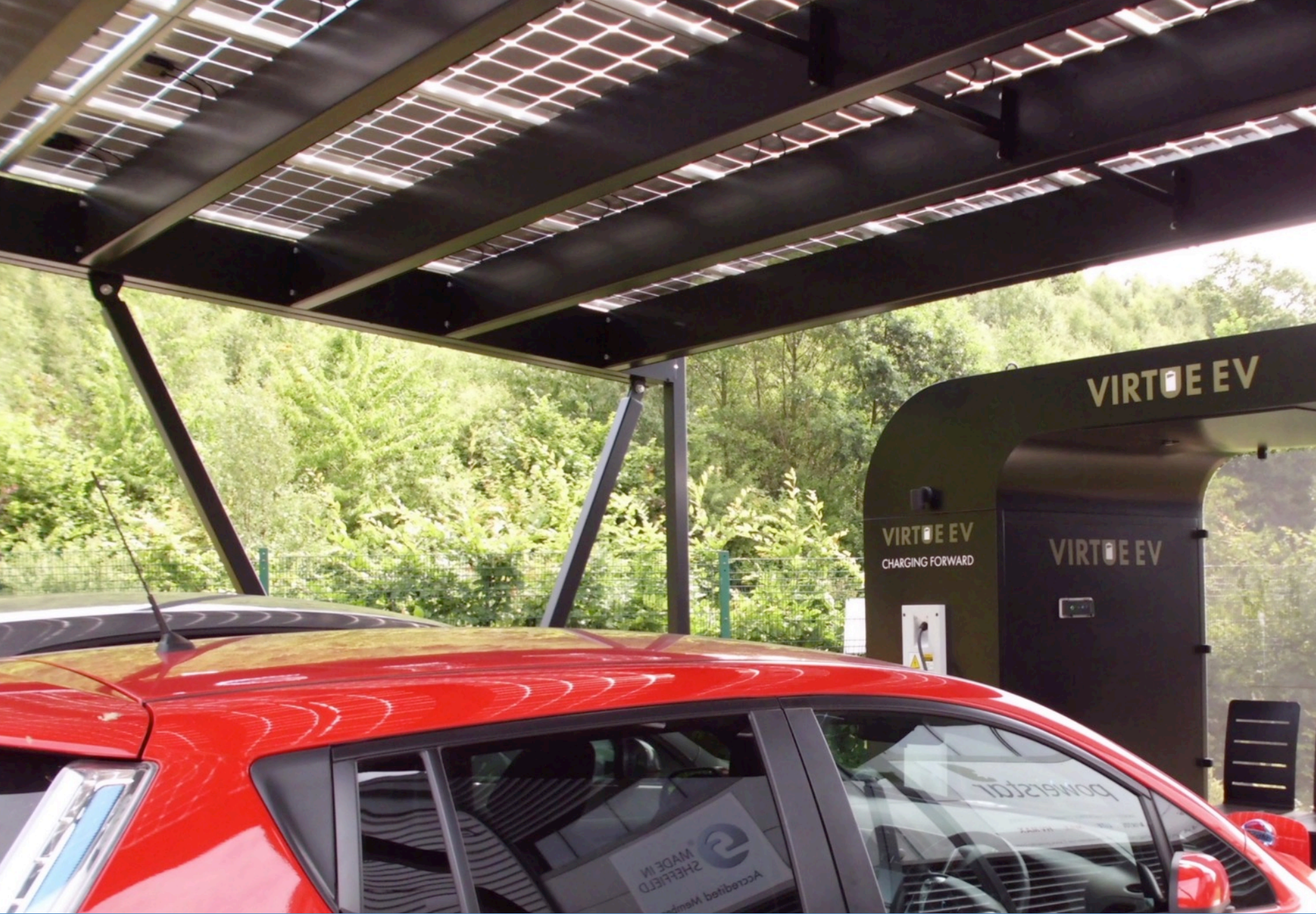
Flexisolar PV/EV/ESS System - Sheffield, UK
