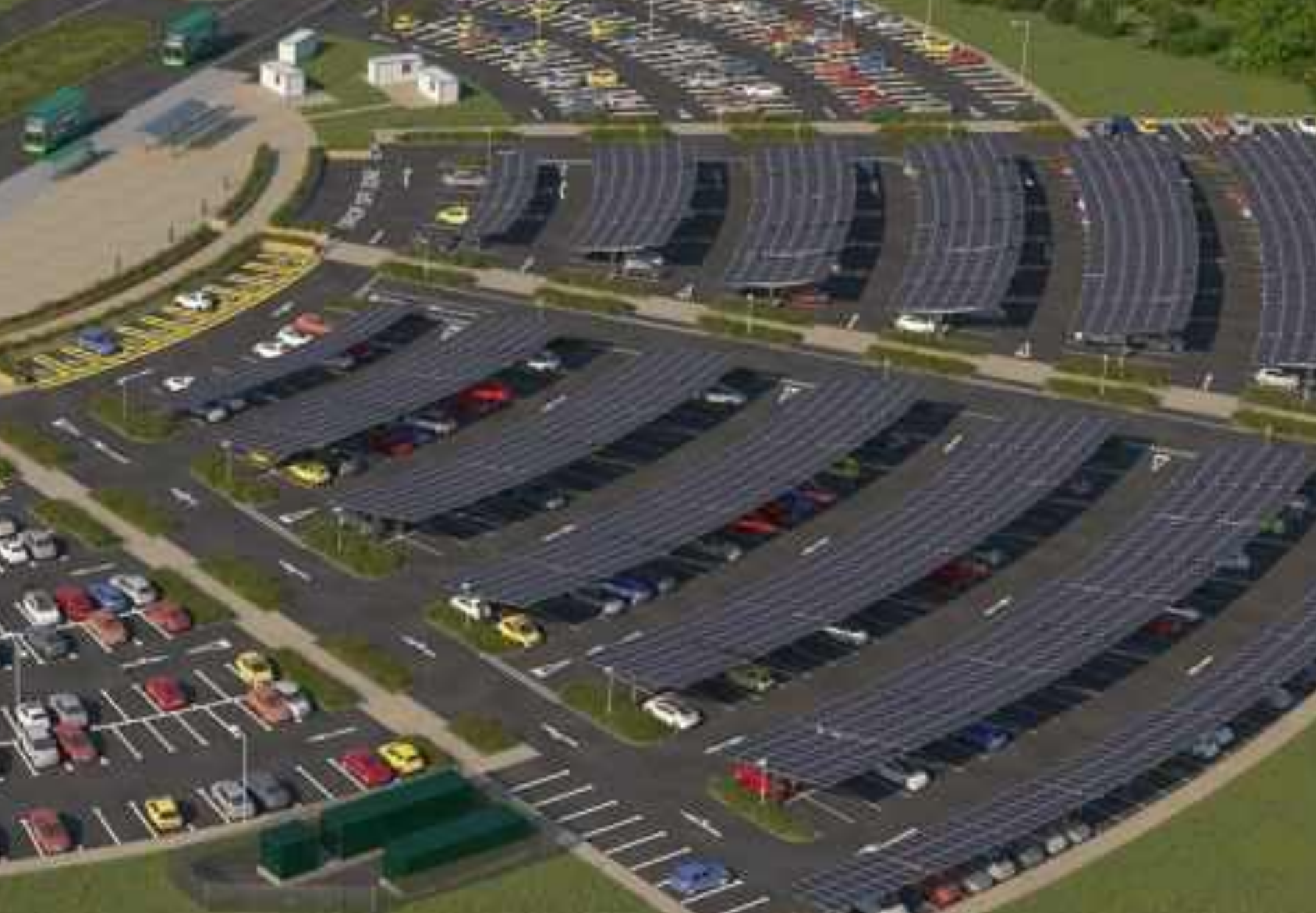
Flexisolar PV/EV/ESS System - Cambridge, UK
